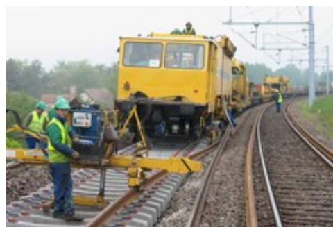
Longs Rails soudés sur traverses béton
