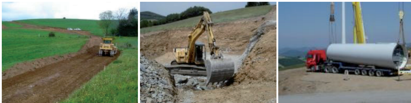
Photographie 94 : Illustration d'un chantier éolien
