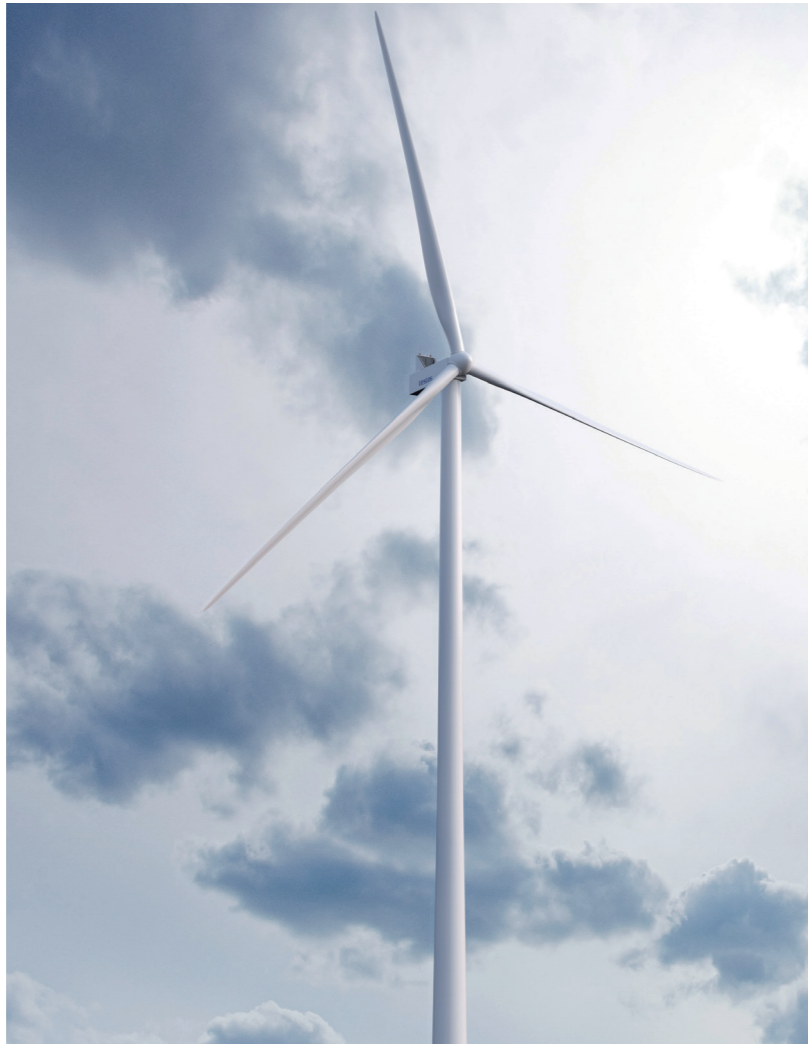
Photographie 90 : Éolienne Vestas V150 - 5,6 MW.
