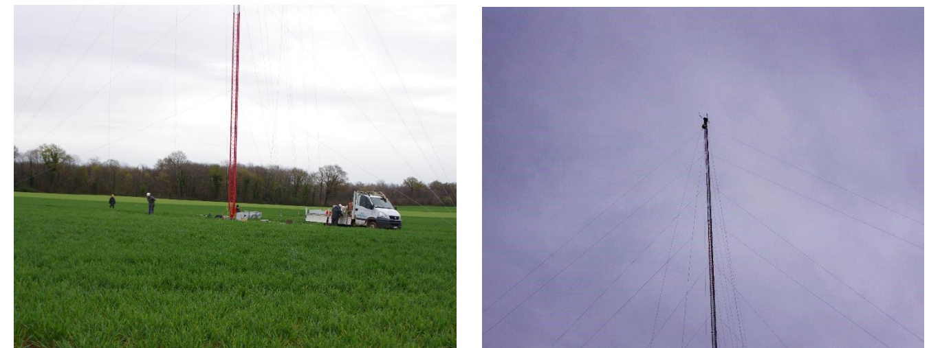
Figure 11 : Installation du mât de mesure : à gauche au sol ; à droite à 100m de hauteur.
