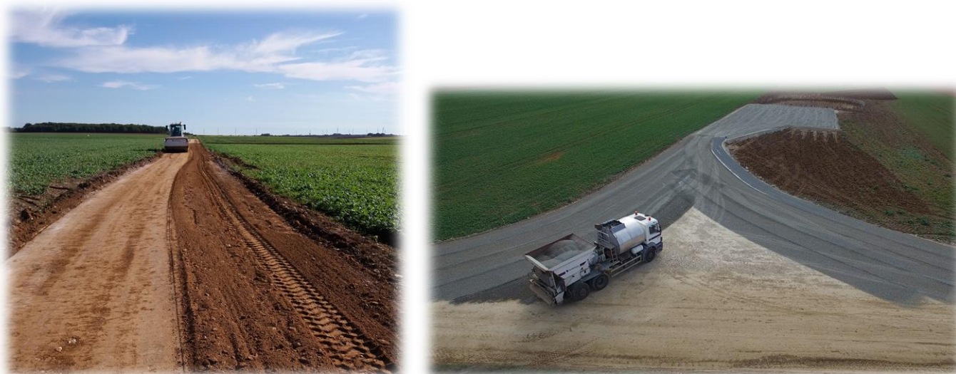
Figure 15 : Étapes de création de pistes (Source : ERG DÉVELOPPEMENT FRANCE)
