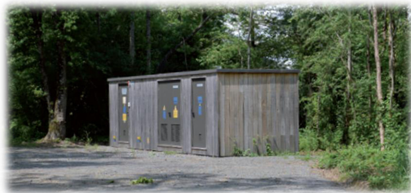
Figure 291 : Exemple d'un poste de livraison recouvert d'un bardage bois, dans un contexte forestier (parc éolien d'Adriers-Tageau dans le département de la Vienne 86)
