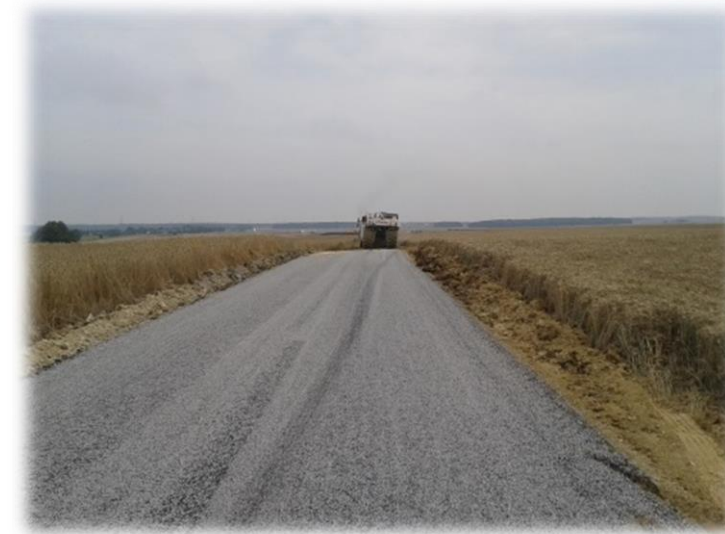
Illustration 224 : Chemin d'accès en grave compactée
